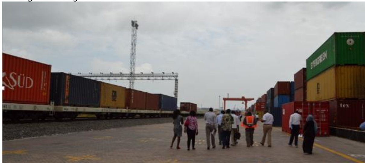
Terminal des cargaisons transportées par chemin de fer à écartement standard à Port Reitz. L'équipe d'enquête a remarqué que l'espace pour le stockage des conteneurs chargés et vides en attente d'être évacués n'est pas approprié compte tenu du volume manutentionné à cette installation
