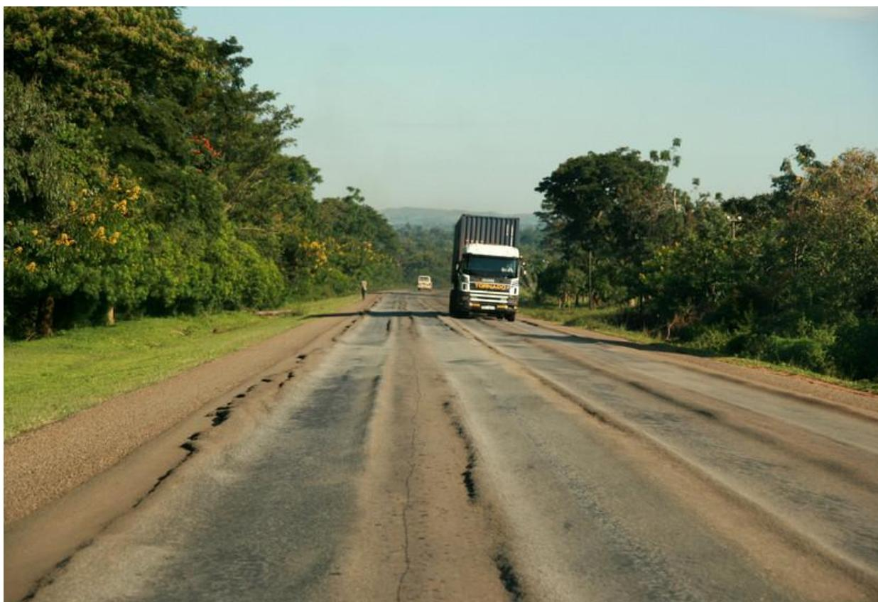
**Photo d'archives:** La route ci-dessus a été endommagée à cause des surcharges à l'essieu. Les pneus exercent une pression sur la route en fonction de la charge à l'essieu. Le dépassement de la limite de la charge à l'essieu entraîne la destruction de la route.
