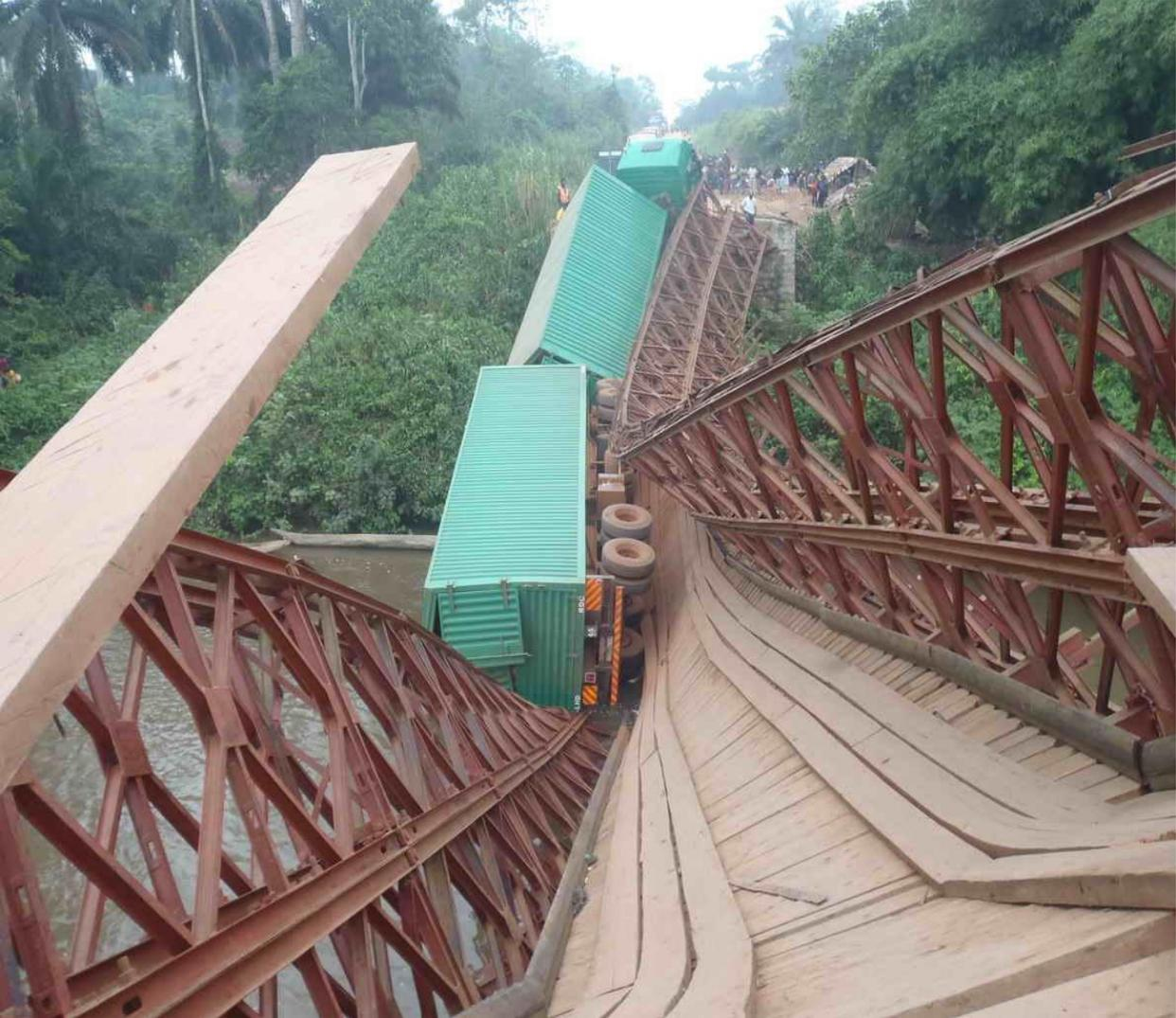
**Photo d'archives:** Des accidents comme celui-ci peuvent être évités en observant les limites du Poids Brut des Véhicules pour la sauvegarde des ponts. Cet accident a bloqué beaucoup d'autres utilisateurs de la route.
